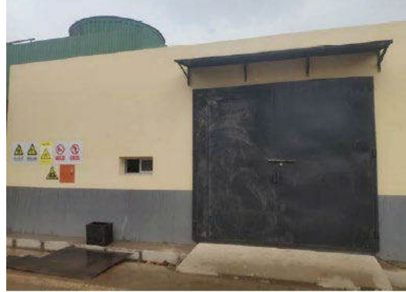
依托厂区危废暂存间
