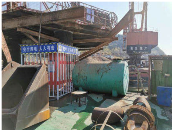
7#泊位舱底油污水、船舶生活污水收集罐
