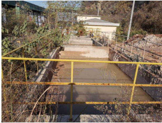
1#泊位厂区废水沉淀池
