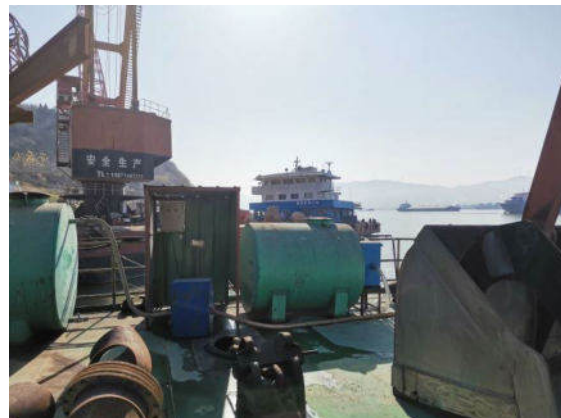
7#泊位舱底油污水、船舶生活污水收集罐
