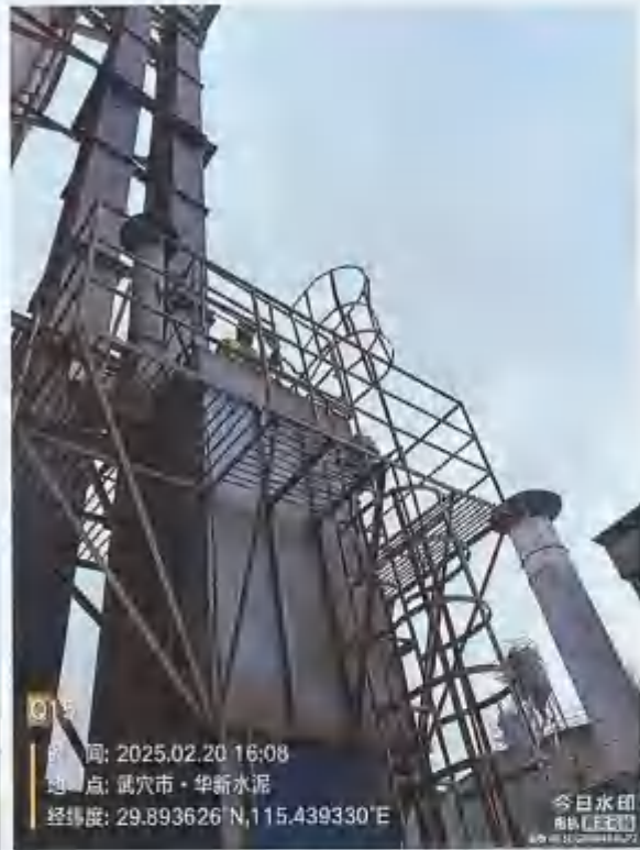
DA169-K1 窑尾袋收尘器废气排气筒
